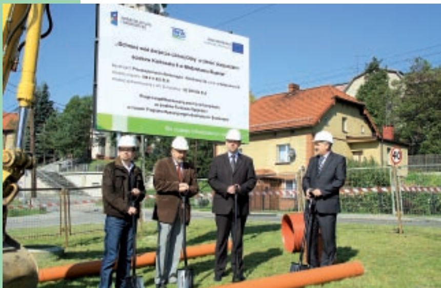
Symboliczne rozpoczęcie inwestycji wodno-kanalizacyjnej w powiecie wodzisławskim
