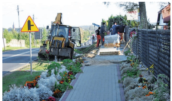
W Kopalni podczas prac kanalizacyjnych i drogowych
