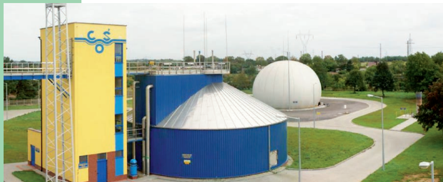
Oczyszczalnia „Warta”, w głębi zbiornik biogazu
